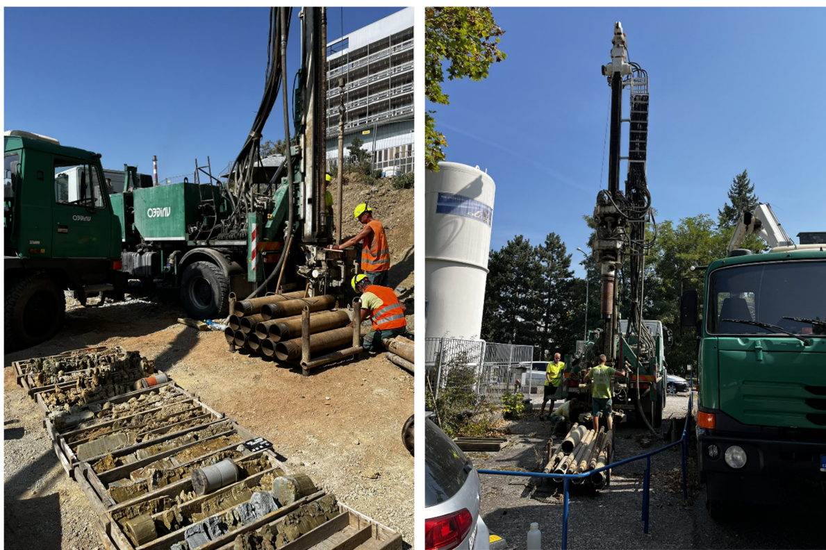
Obr. 2.2.1 Vrtná souprava HVS 482 a vrtné práce na sondě SO01 J1 a SO05 J4
